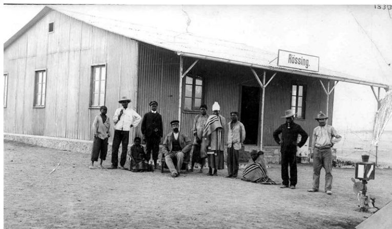
Bahnhof Rössing an der Otavi-Bahn -Bildarchiv Uni Frankfurt
